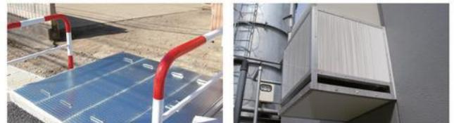
●排水溝の水音対策。蓋に設置 ●屋外ダクトの騒音対策に活用
